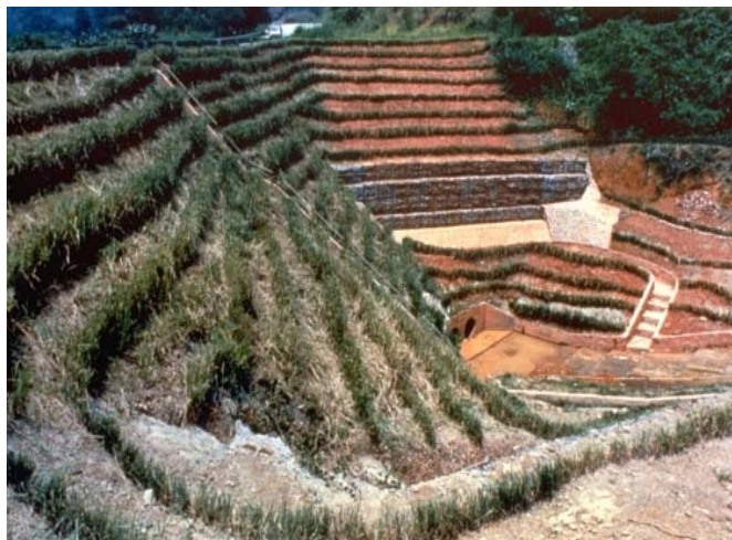
Un imponente consolidamento con il Vetiver abbinato ad opere civili
