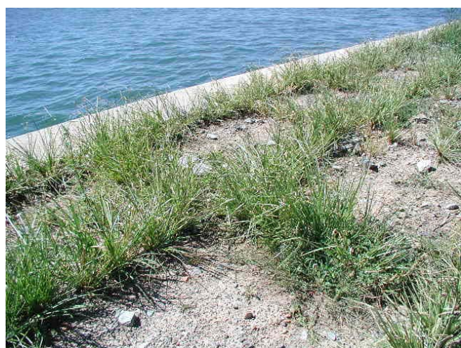
Un altro impianto di Vetiver in Italia a consolidamento di un terrapieno esposto alla forza del mare
