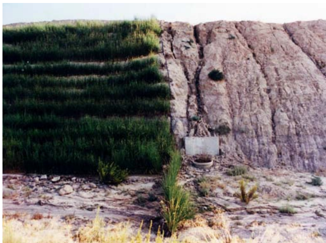
Parete ad alta pendenza consolidata con piante ingegnere: si noti l'erosione nella parte non consolidata
