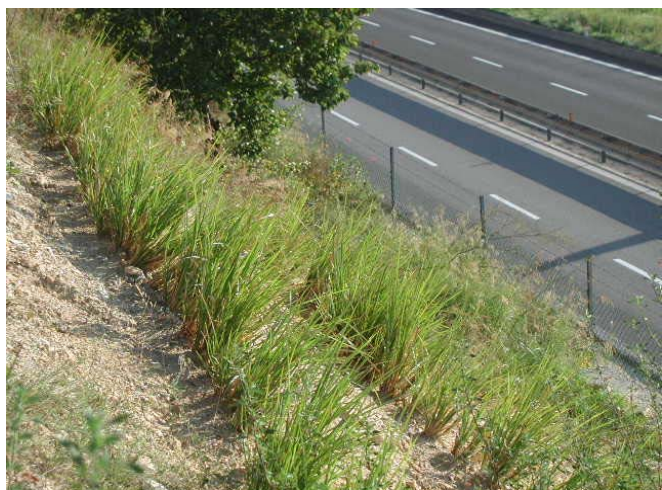
Un impianto di Vetiver realizzato in Italia lungo un'autostrada
